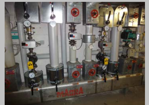
Heizungsverteiler
