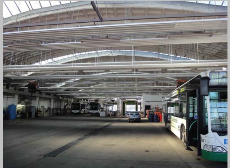
Anordnung der Strahlungsheizflächen in der Reparaturhalle
